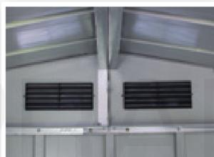
Rejillas de ventilación de la caseta en el frontal en todos los modelos.
