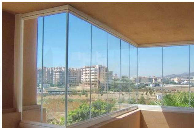
Se puede instalar una puerta fija en el sistema, podemos elegir el sentido de apertura de la misma, incluso hacia los dos lados. Se le puede añadir cualquier cierre de seguridad
