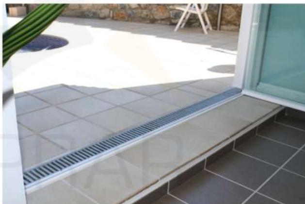
El sistema se puede embutir totalmente y crear un desagüe para evacuar el agua producida por la condensación en la parte interior del cristal
