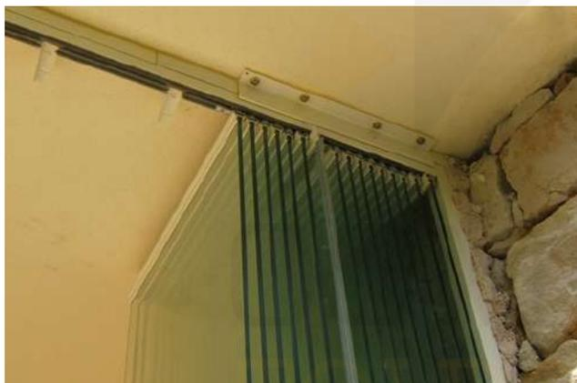
Para instalaciones muy extensas basta con una simple pletina de seguridad en el techo
