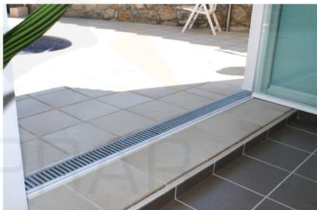
Embutido con desagüe
